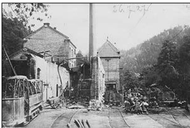
Vozovna po požáru v roce 1927
